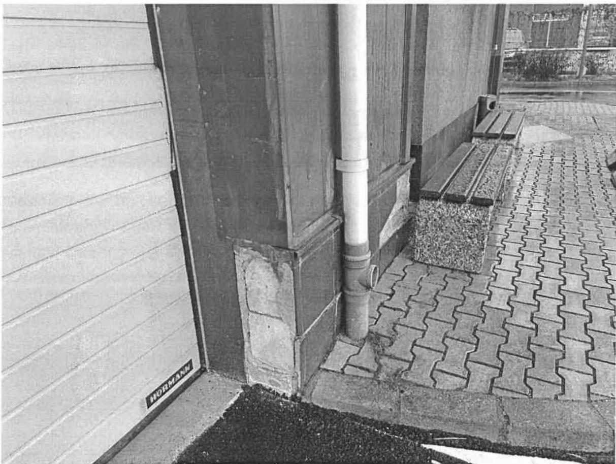
Refacerea trotuarului in zonele deteriorate, Refacerea termoizolatiei la soclu pe toata zona trotuarului. Se va inlocui gresia aplicata pe soclu cu o tencuiala la soclu de tip marmoron pentru a spori eficienta din punct de vedere energetic .
